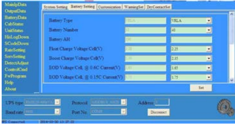
Şekil 6-3 İzleyici yazılımla yapılandırma
